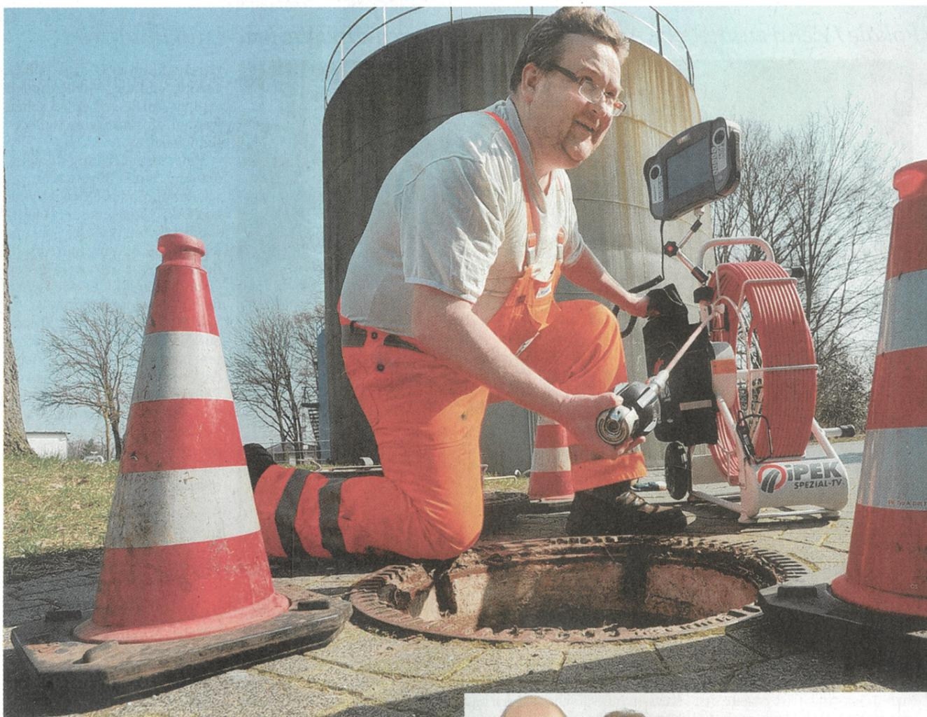
**Film ab:** Bei dem Pilotprojekt, das die Stadt Enger an der Würdebrinkstraße plant, soll eine Kamera vom öffentlichen Kanalsystem aus ins Netz eingebracht werden und die Abwasserleitungen auf den Privatgrundstücken auf Schäden untersuchen.
